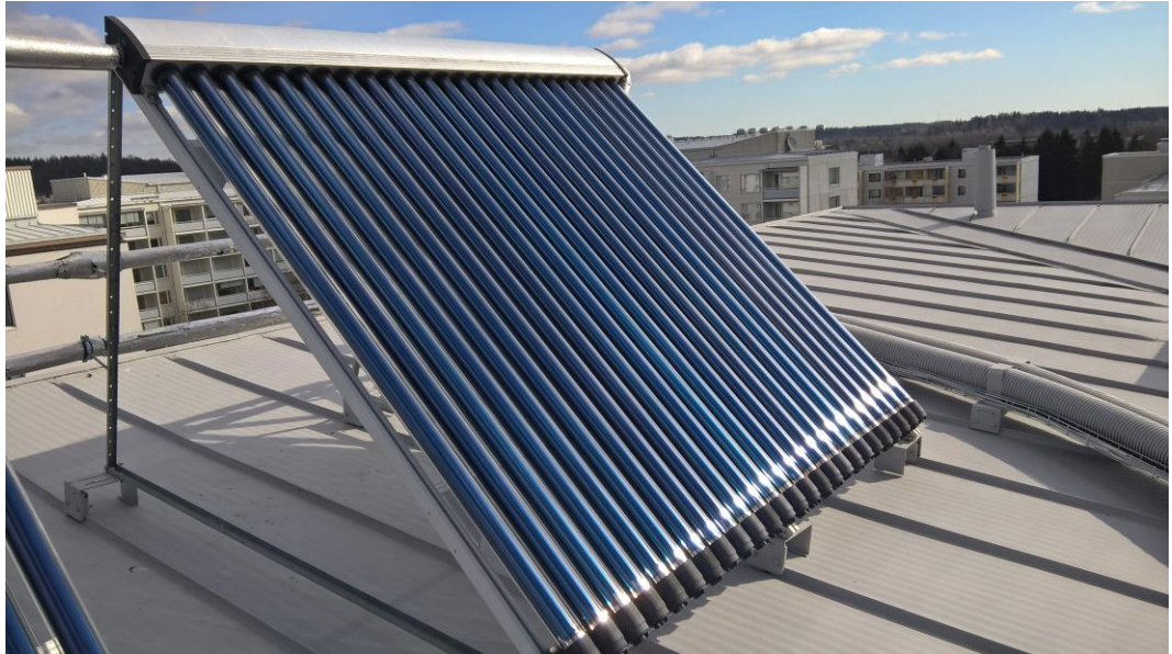
KUVA 5. Alumiiniprofiileilla on luotu haluttu asennuskulma aurinkokeräimille
