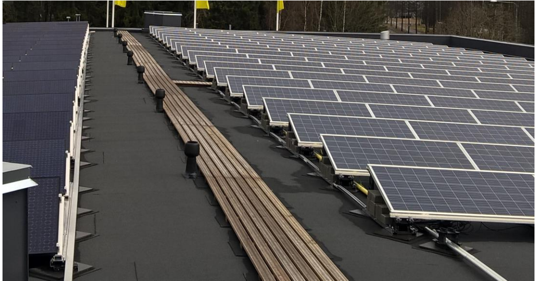
KUVA 6. Katolle asennettu kulkureitti
